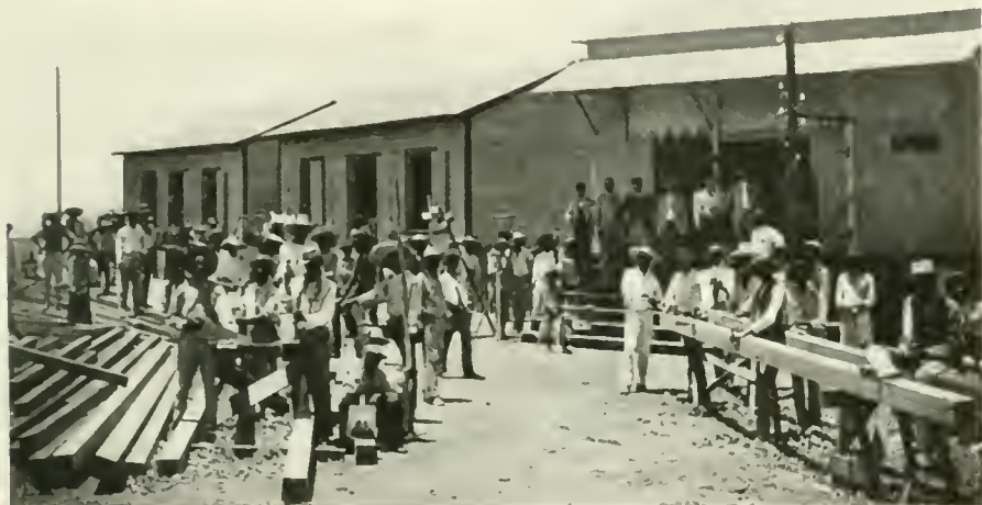
UN CHANTIER A JÉRÉMIE. — CONSTRUCTION DE L'USINE D'ÉLECTRICITÉ
